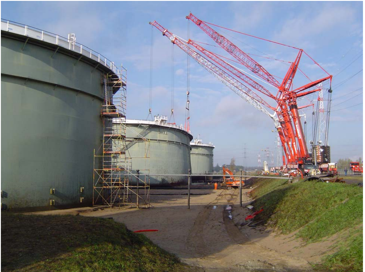
Figuur 3 : Foto van de grote kranen die opslagtank D2 stabiliseren
